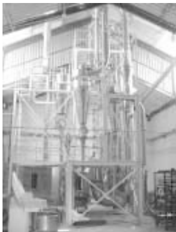
Fot. N° 5. Vista panorámica del secador
